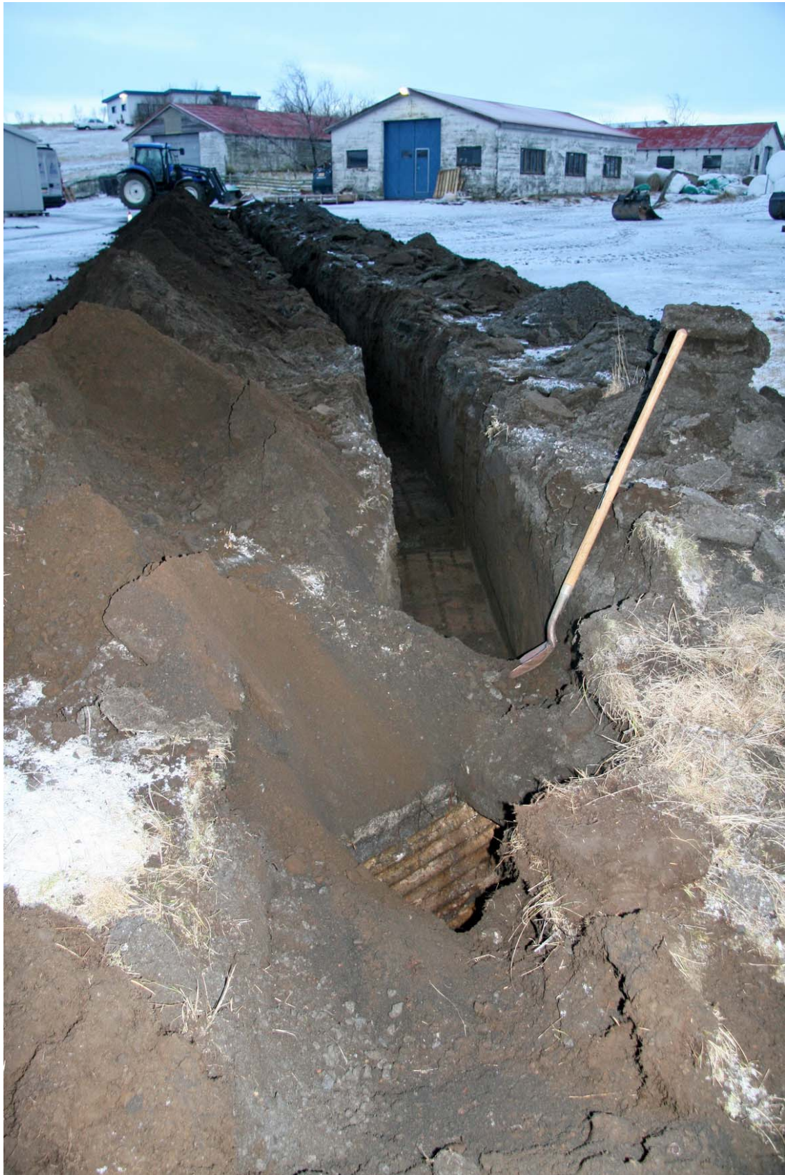
Mynd 5. Mynd sem sýnir opið ofan í steypu rotþróna og afstöðu hennar (GÓL-2007-25-19).
