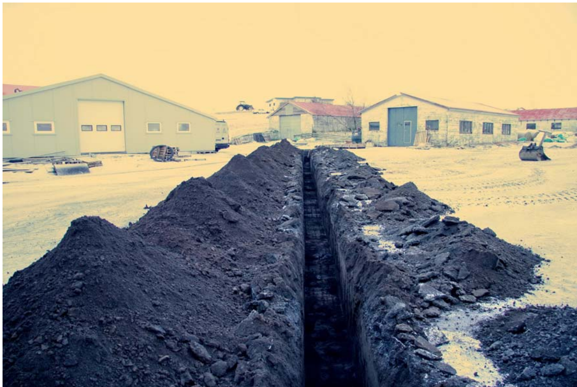
Mynd 2. Horft til norðausturs í átt að vélaverkstæðinu, þar sem tengjast þarf virkri vatnsleiðslu (GÓL-2007-25-6).
