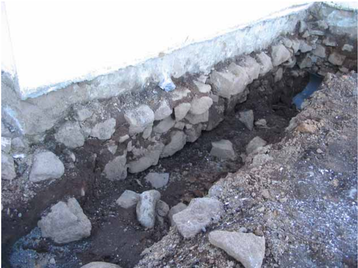
Mynd 1. Skurður við vesturhlið útbýggingar. Efst sést múrhúð sem sýnir hvar yfirborð jarðvegs var fyrir rannsókn. Þar undir er um 20 cm niður að sökkli hússins, sem sýnir líklega upphaflegt yfirborð umhverfis Nesstofu. Sökkullinn er úr grjóti og um 15 – 20 cm breiðari en veggurinn. Í botni skurðarins fyrir miðju, sjást leifar af innri og ytri veggjarbrún grjóthleðslu sem liggur þvert yfir skurðinn. Sótblandin gólfskán var í horninu, hægra megin við vegginn (GÓL2006-1-16).
